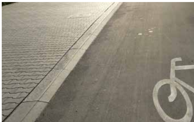
Zdjęcie 17 Obniżenie drogi dla rowerów względem chodnika przy pomocy krawężnika utożsamionego „na płask”. Wrocław, Polska
