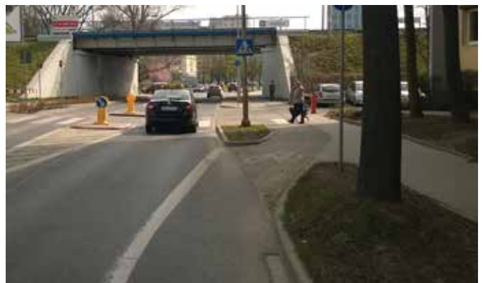
Zdjęcie 46 Zjazd z pasa ruchu dla rowerów na drogę dla rowerów. Wrocław, Polska
