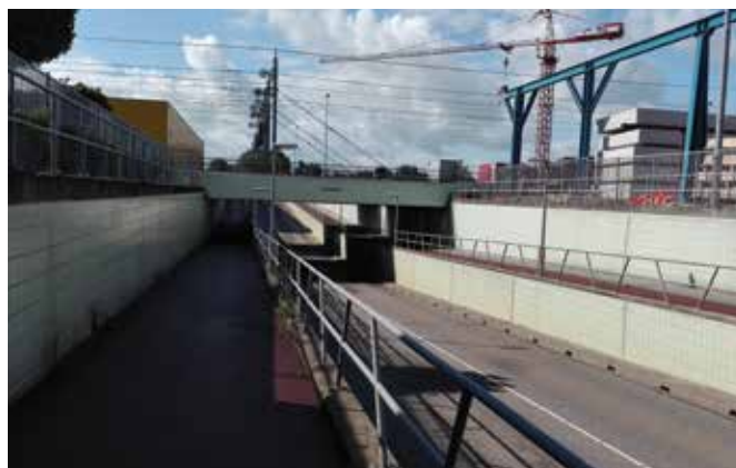
Zdjęcie 13 Niweleta drogi dla rowerów prowadzona powyżej niwelety jezdni. Amsterdam, Holandia
