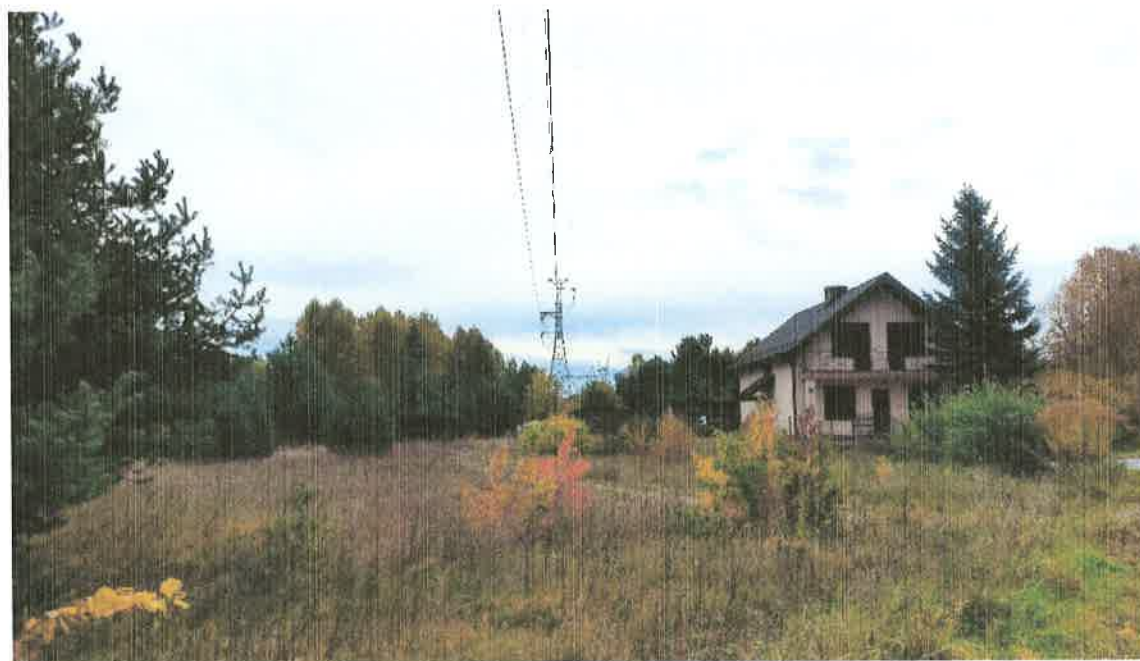
Zdjęcie nr 4. LWN 220 kV Joachimów Łagisza Wrzosowa, przęsło 113-114.
