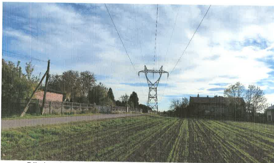
Zdjęcie nr 2. LWN 220 kV Joachimów Łagisza Wrzosowa, przesło 58-59.
