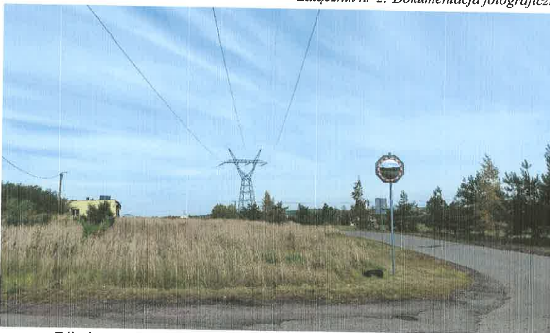
Zdjęcie nr 1. LWN 220 kV Joachimów Łagisza Wrzosowa, przesło 44-45.
