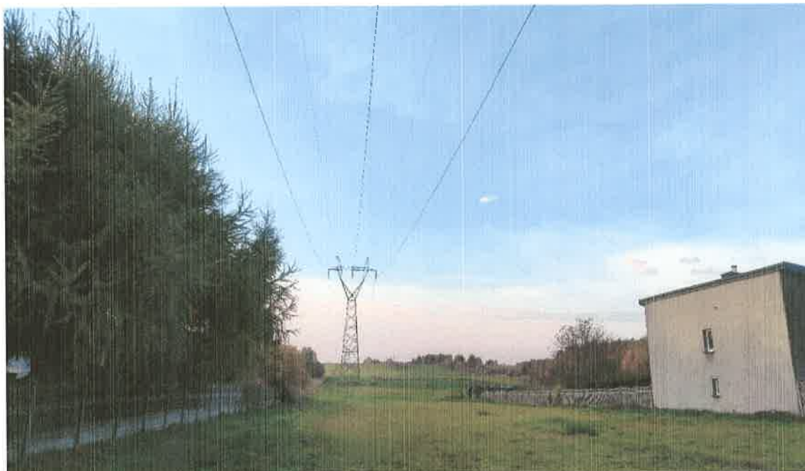
Zdjęcie nr 3. LWN 220 kV Joachimów Łagisza Wrzosowa, przęsło 72-73.
