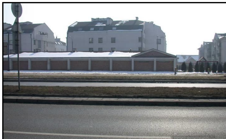
Fot. 11. Ekranowanie obiektów mieszkalnych przez garaże usytuowane bezpośrednio przy ulicy (Polska)
