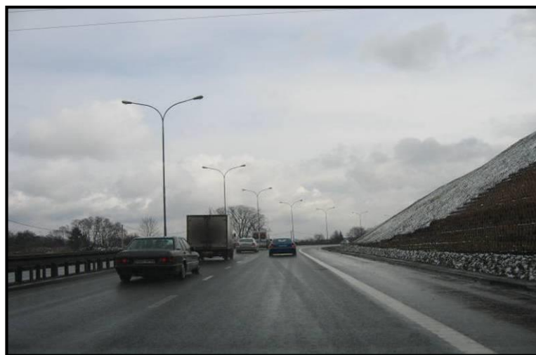
Fot. 9. Przykład wału ziemnego chroniącego zabudowę przed oddziaływaniem hałasu (odcinek drogi krajowej nr 94 Kraków – Tarnów)
