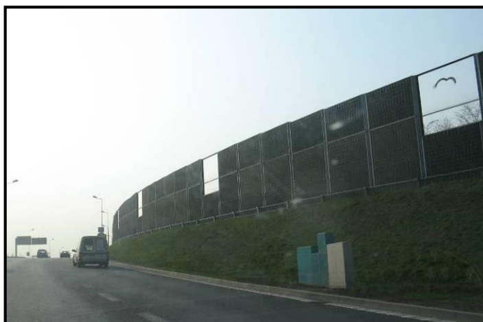
Fot. 10. Przykład kombinacji ekranu ziemnego z ekranem akustycznym (droga krajowa nr 94 na odcinku Kraków – Tarnów)
