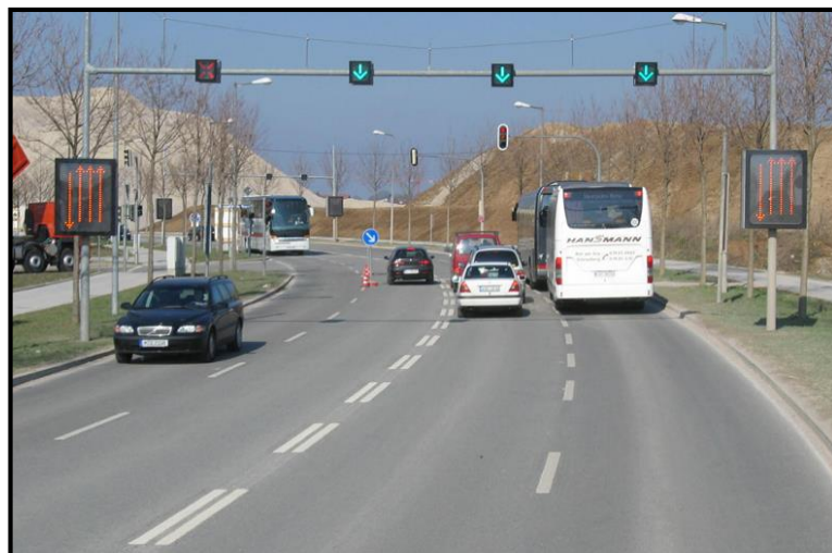
Fot. 3. Przykład sterowania ruchem na drodze jednojezdniowej, czteropasowej w pobliżu terenów targowych, gdzie następują znaczne problemy z płynnością ruchu w określonych kierunkach i porach dnia (Monachium, Niemcy)
