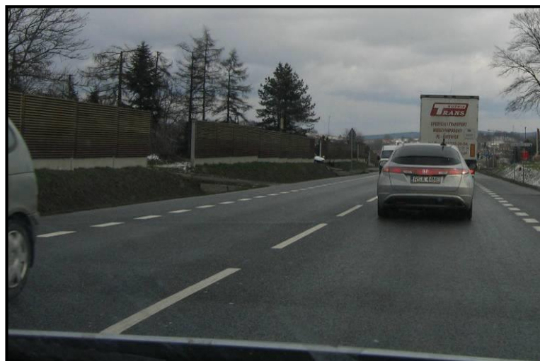
Fot. 2. Konieczność zapewnienia zjazdu do posesji – przerwanie ciągłości ekranu akustycznego i słaba jego skuteczność (droga krajowa nr 94 na odcinku Kraków – Tarnów)
