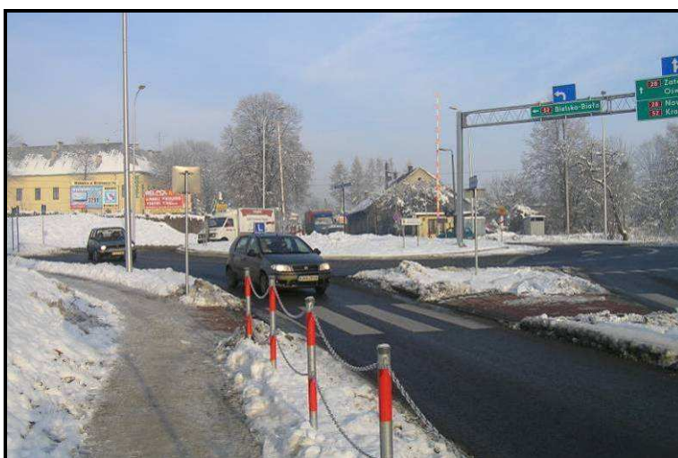
Fot. 7. Przykład ograniczenia prędkości i jednoczesnego utrzymania płynności ruchu poprzez zastosowanie ronda (droga krajowa nr 52 - Wadowice)
