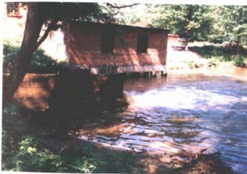
Jak wyżej Stanowisko dolne jazu – widoczny budynek siłowni wodnej
