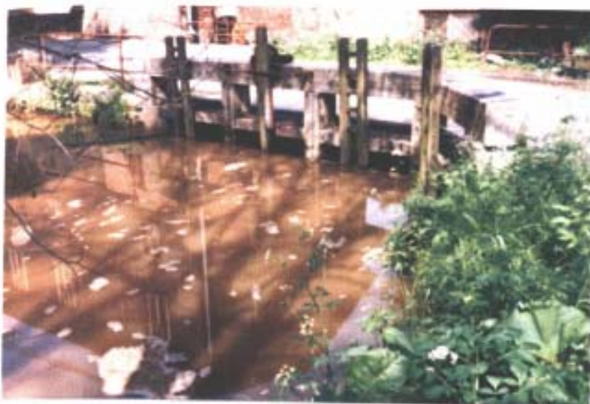
Istniejący jaz piętrzący wodę przy młynie w Białej Wielkiej przewidywany do wykorzystania dla planowanego zbiornika
