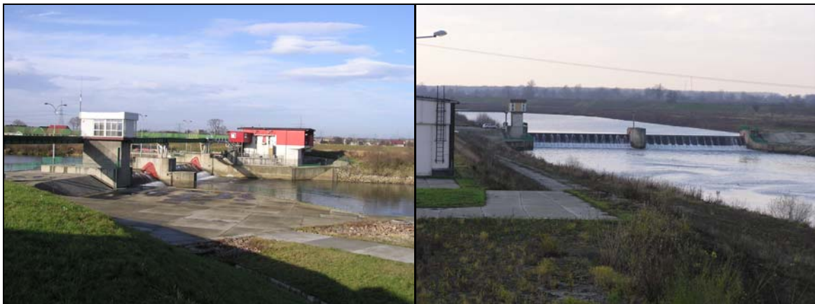
Fot. 2. Stopnie w Dworach (po lewej) i w Smolicach (po prawej)
