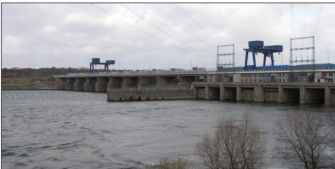
Fot. 1. Zaporą we Włocławku od wody dolnej (część przepławki dla ryb poniżej zapory)
