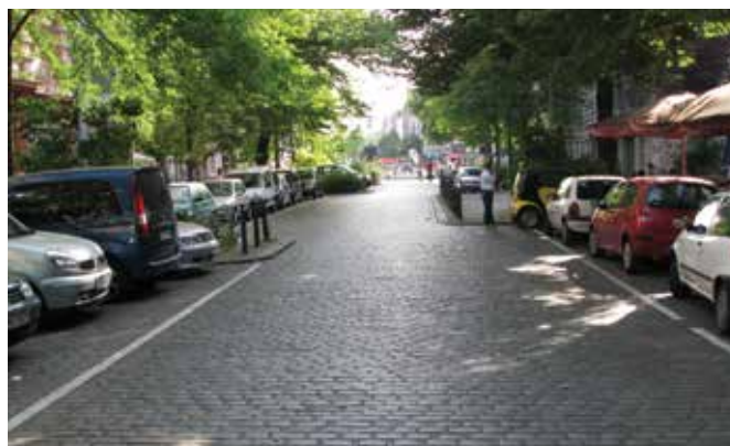
Zdjęcie 30 Esowanie toru jazdy. Berlin, Niemcy
