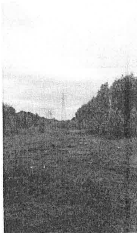
Przęsło 52 – 53. Widok w kierunku słupa nr 53
