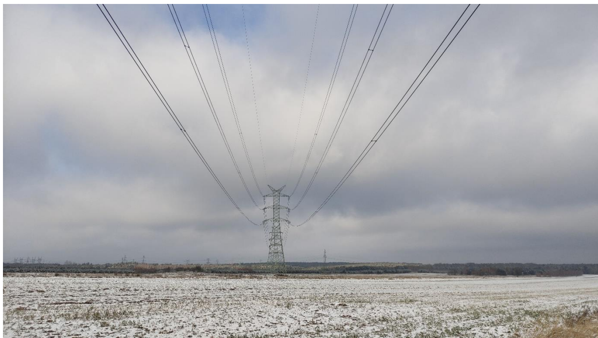
Zdjęcie nr 1. Dwutorowa Napowietrzna Linia Elektroenergetyczna 400 kV relacji Dobrzeń - Trębaczew i Trębaczew - Joachimów – widok fragmentu obiektu.
