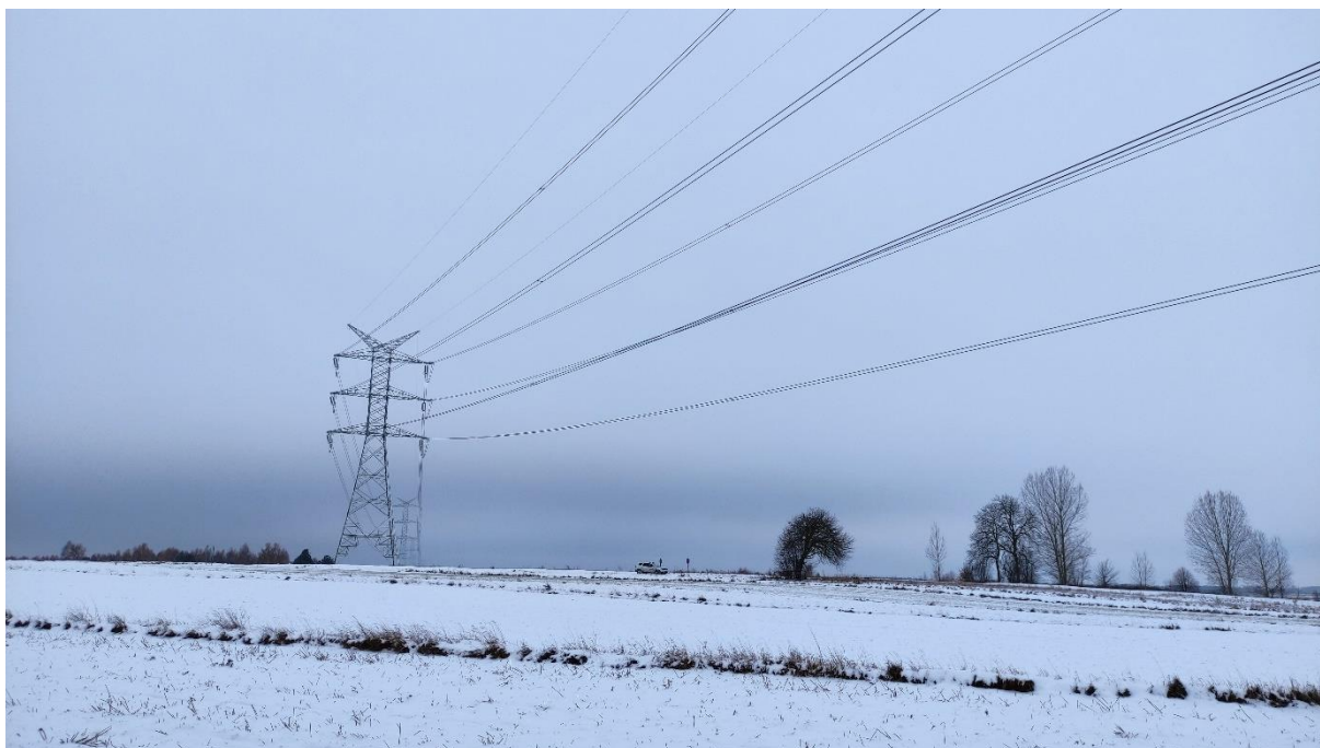
Zdjęcie nr 23. Dwutorowa Napowietrzna Linia Elektroenergetyczna 400 kV relacji Dobrzeń - Trębaczew i Trębaczew - Joachimów – widok fragmentu obiektu.
