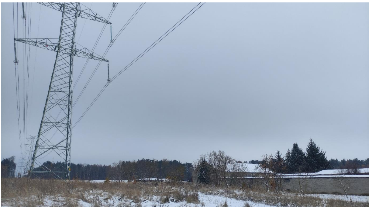
Zdjęcie nr 26. Dwutorowa Napowietrzna Linia Elektroenergetyczna 400 kV relacji Dobrzeń - Trębaczew i Trębaczew - Joachimów – widok fragmentu obiektu.
