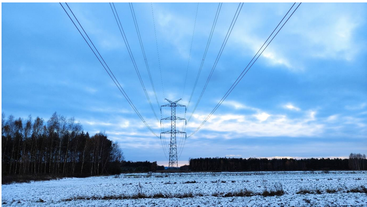
Zdjęcie nr 16. Dwutorowa Napowietrzna Linia Elektroenergetyczna 400 kV relacji Dobrzeń - Trębaczew i Trębaczew - Joachimów – widok fragmentu obiektu.
