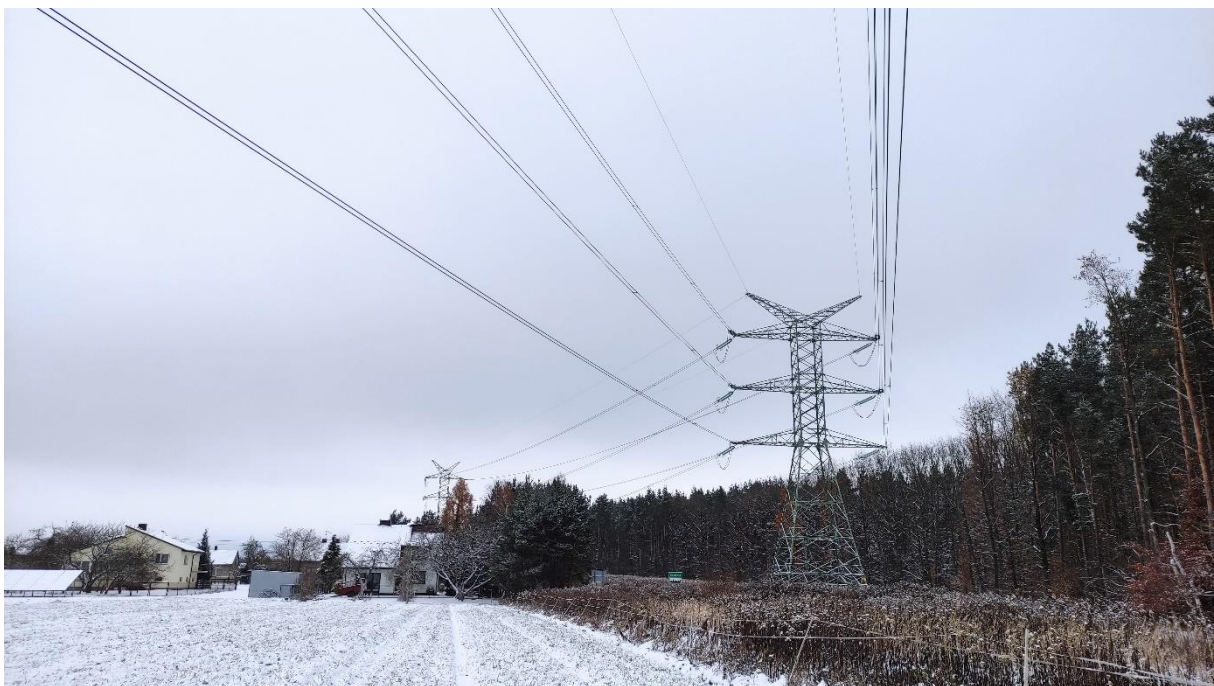
Zdjęcie nr 36. Dwutorowa Napowietrzna Linia Elektroenergetyczna 400 kV relacji Dobrzeń - Trębaczew i Trębaczew - Joachimów – widok fragmentu obiektu.
