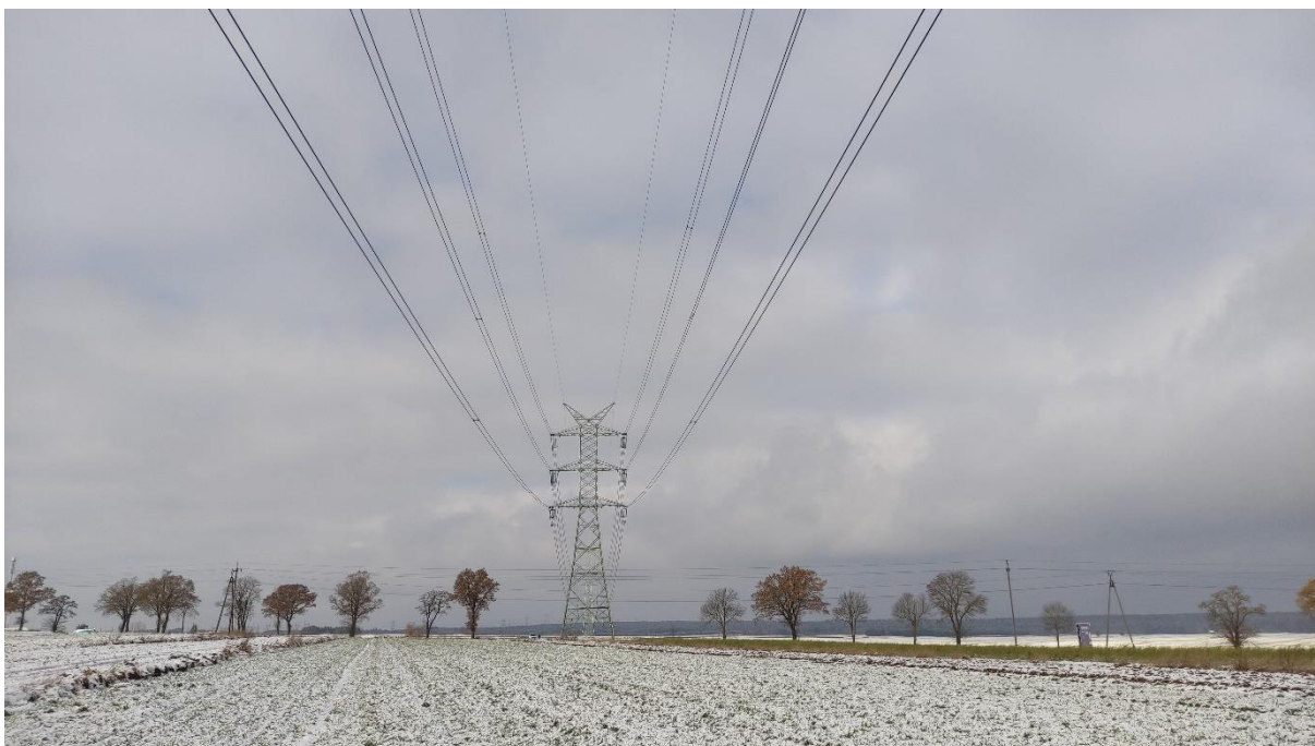
Zdjęcie nr 3. Dwutorowa Napowietrzna Linia Elektroenergetyczna 400 kV relacji Dobrzeń - Trębaczew i Trębaczew - Joachimów – widok fragmentu obiektu.
