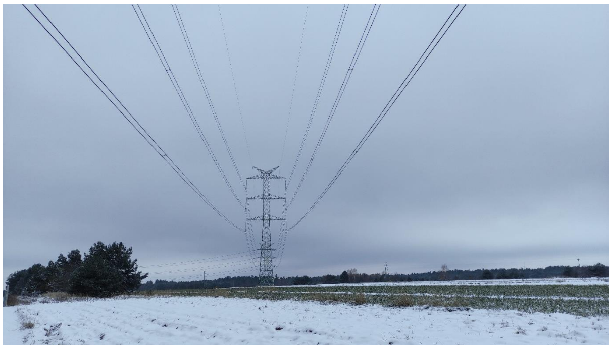
Zdjęcie nr 37. Dwutorowa Napowietrzna Linia Elektroenergetyczna 400 kV relacji Dobrzeń - Trębaczew i Trębaczew - Joachimów – widok fragmentu obiektu.
