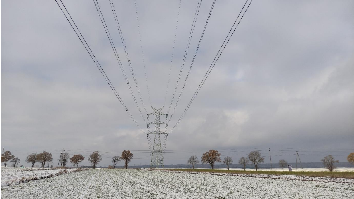
Zdjęcie nr 3. Dwutorowa Napowietrzna Linia Elektroenergetyczna 400 kV relacji Dobrzeń - Trębaczew i Trębaczew - Joachimów – widok fragmentu obiektu.
