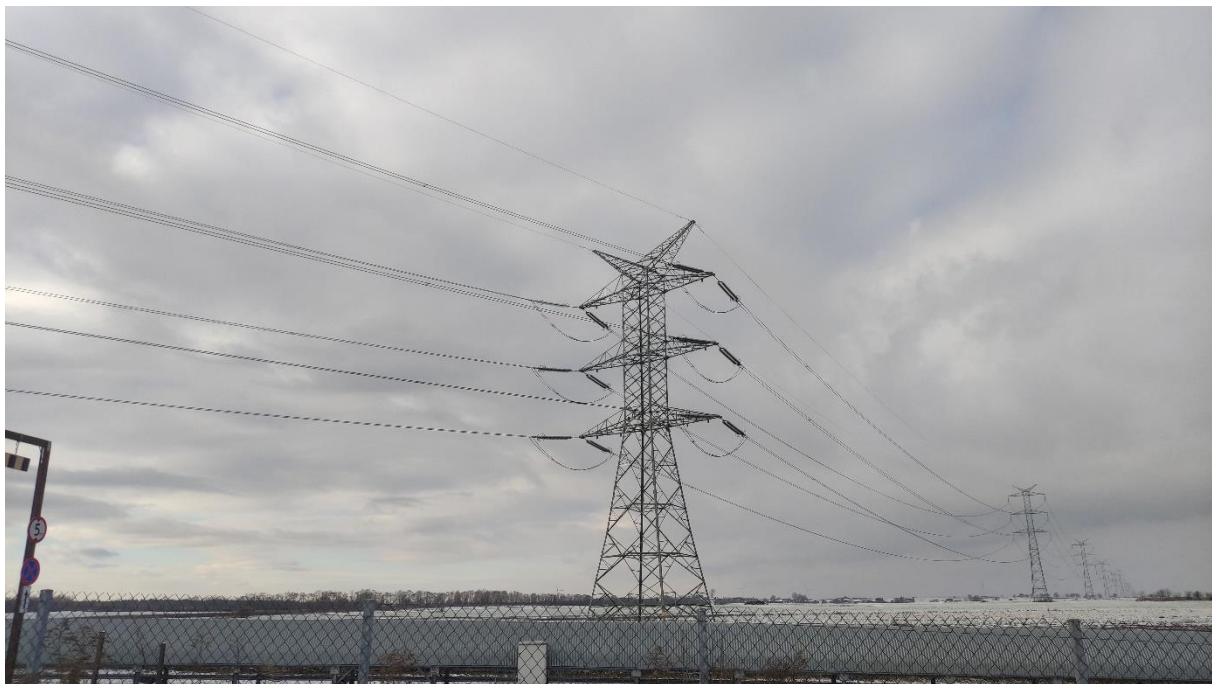
Zdjęcie nr 8. Dwutorowa Napowietrzna Linia Elektroenergetyczna 400 kV relacji Dobrzeń - Trębaczew i Trębaczew - Joachimów – widok fragmentu obiektu.
