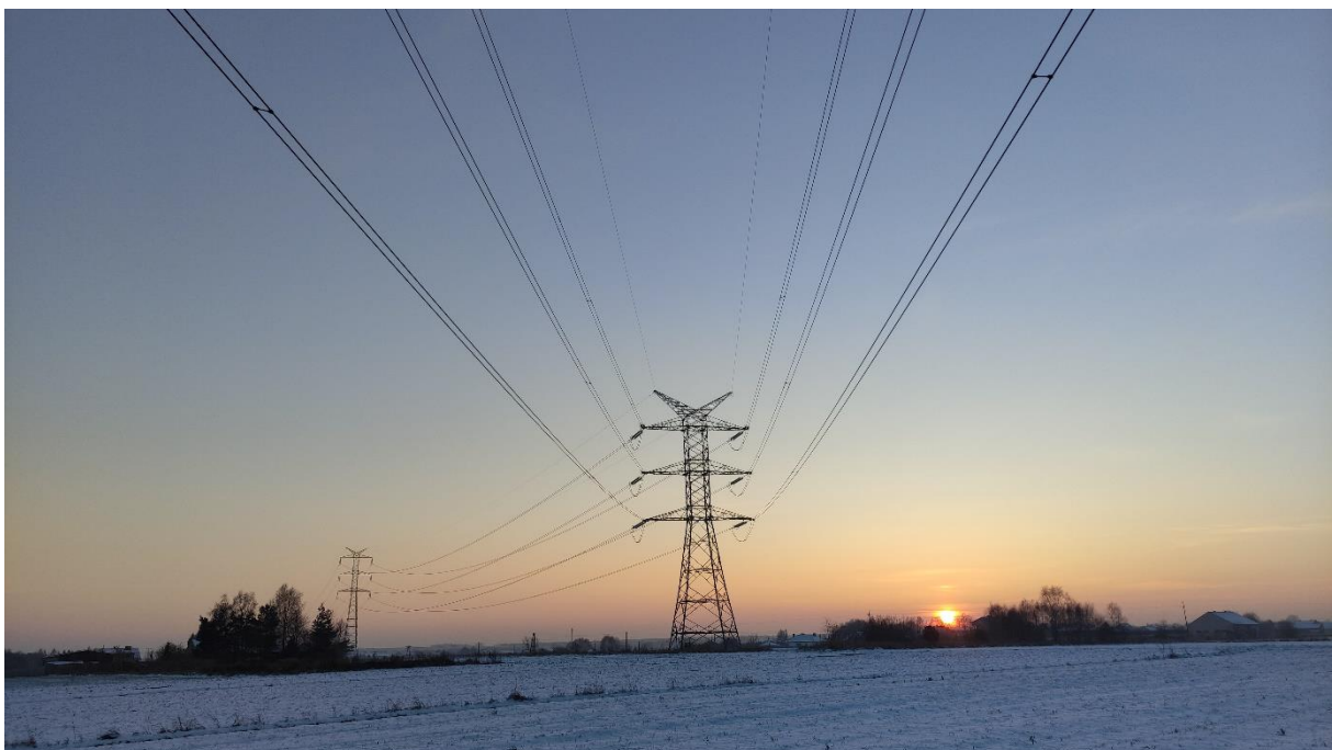
Zdjęcie nr 52. Dwutorowa Napowietrzna Linia Elektroenergetyczna 400 kV relacji Dobrzeń - Trębaczew i Trębaczew - Joachimów – widok fragmentu obiektu.
