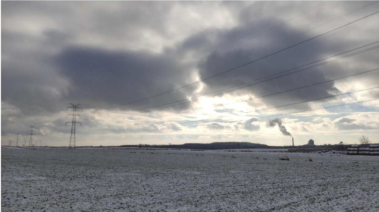
Zdjęcie nr 5. Dwutorowa Napowietrzna Linia Elektroenergetyczna 400 kV relacji Dobrzeń - Trębaczew i Trębaczew - Joachimów – widok fragmentu obiektu.
