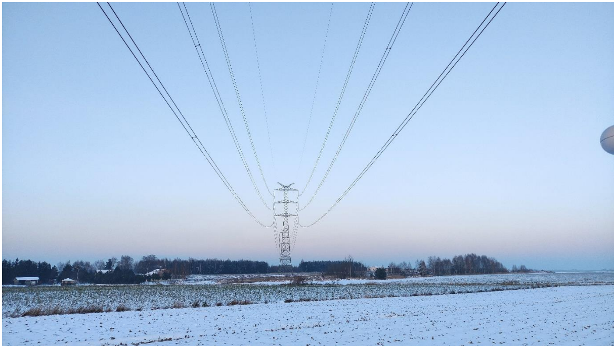
Zdjęcie nr 51. Dwutorowa Napowietrzna Linia Elektroenergetyczna 400 kV relacji Dobrzeń - Trębaczew i Trębaczew - Joachimów – widok fragmentu obiektu.
