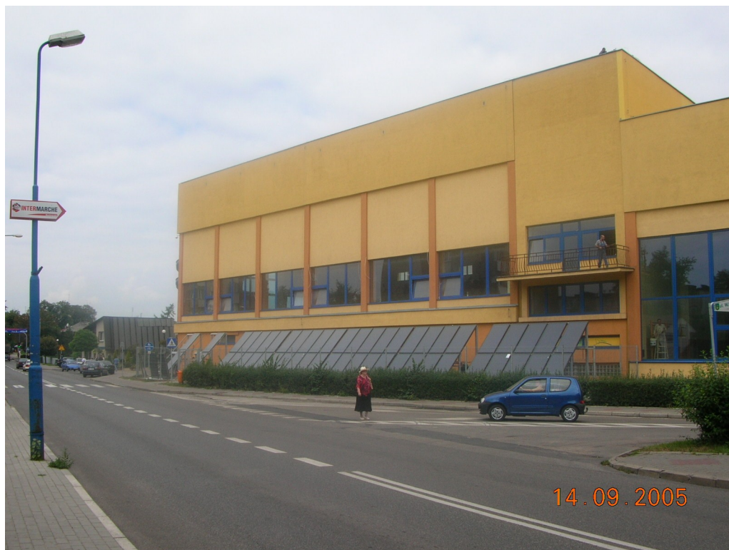
Zdjęcie nr 11 Widok elewacji strona południowa – kolektory słoneczne po remoncie
