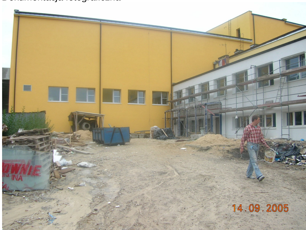
Zdjęcie 9 Prace termomodernizacyjne na elewacji (strona wschodnia).
