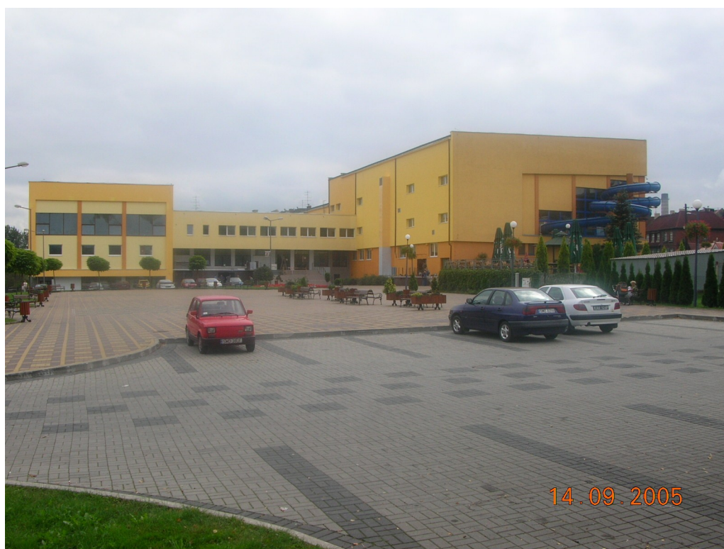
Zdjęcie nr 10 Widok elewacji strona zachodnia po remoncie
