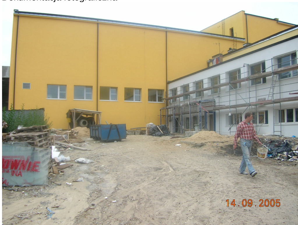
Zdjęcie 9 Prace termomodernizacyjne na elewacji (strona wschodnia).
