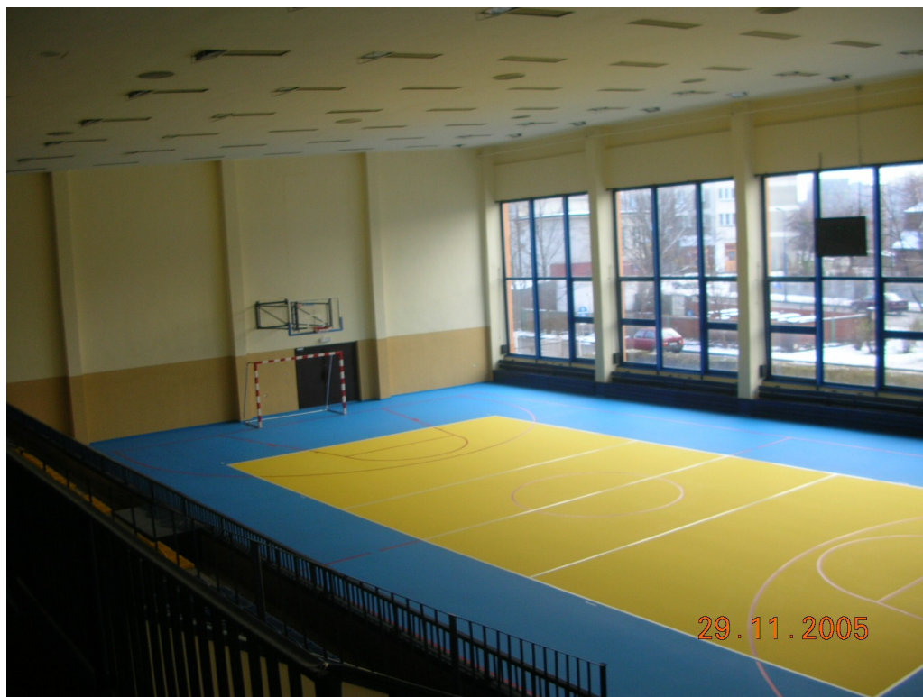
Zdjęcie nr 12 Duża sala gimnastyczna – widok z widowni po remoncie
