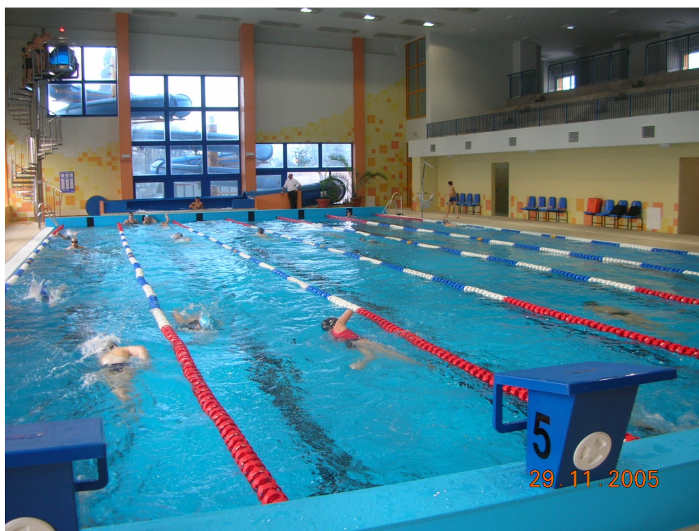
Zdjęcie nr 11 Duży basen (pływacki) w tle zjeżdżalnia po remoncie
